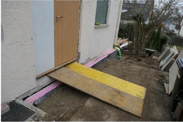
Perimeterdämmung Ostfassade (Eingang)
