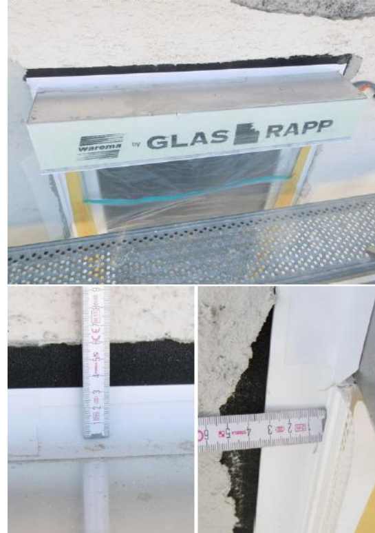
Rahmenüberdämmung oben und seitlich 3 cm + Einbaufuge
