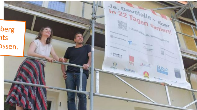
Dorothee Flaig und Achim Schmitt aus Stuttgart sind happy: Nur noch das Gerüst an ihrem komplett sanierten Haus muss abgebaut werden. Foto: Lichtgut/Kovalenko
