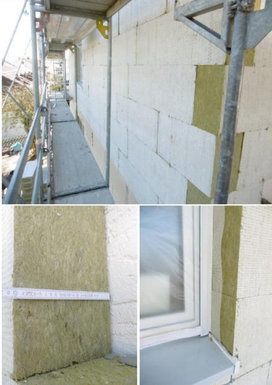
Fassadendämmung
